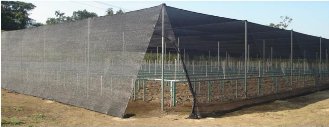
Imagen 1. Modelo de casa sombra tipo plano para zonas sin incidencia de granizadas
