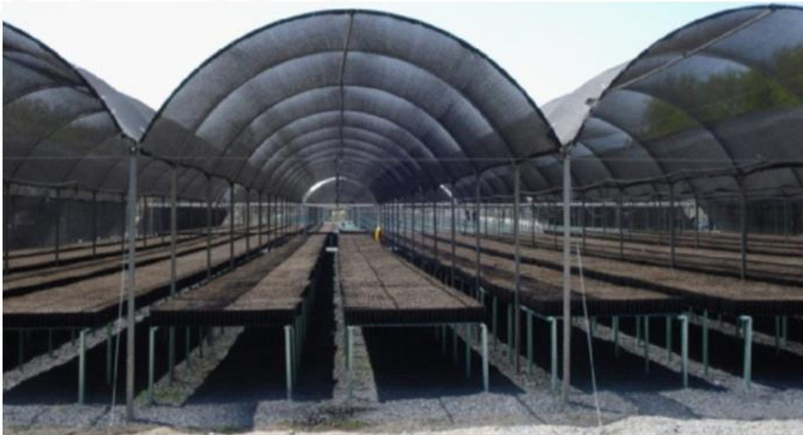
Imagen 2. Modelo de casa sombra tipo multitune para zonas con incidencia de granizadas.
