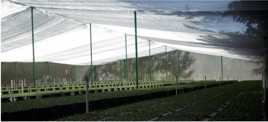
Imagen 3. Modelo de casa sombra a dos aguas para zonas con incidencia de granizadas.
